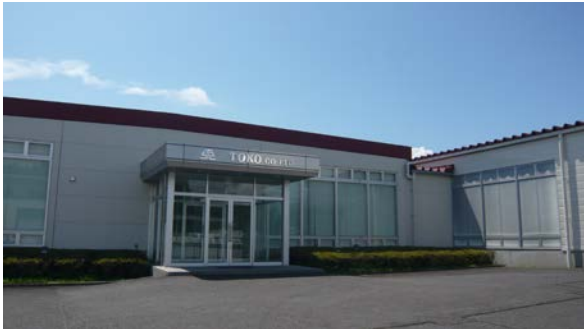
本社ビル入口
